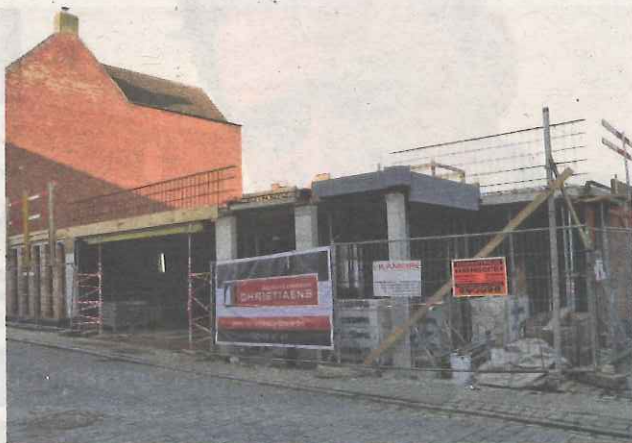
De bouwwerken aan De Rode Klaver zijn recent gestart.
